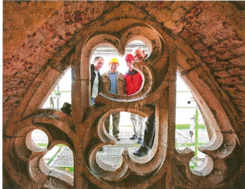
Ein Blick ins fertig restaurierte Maßwerk eines Fensters von St. Georg: Steinmetz Helmut Schneider (links) mit Martin Fricker und Günter Drollinger vom Bauausschuss der Gemeinde sowie Bauleiter Raimund Amann. Foto: Volkmar Könneke
